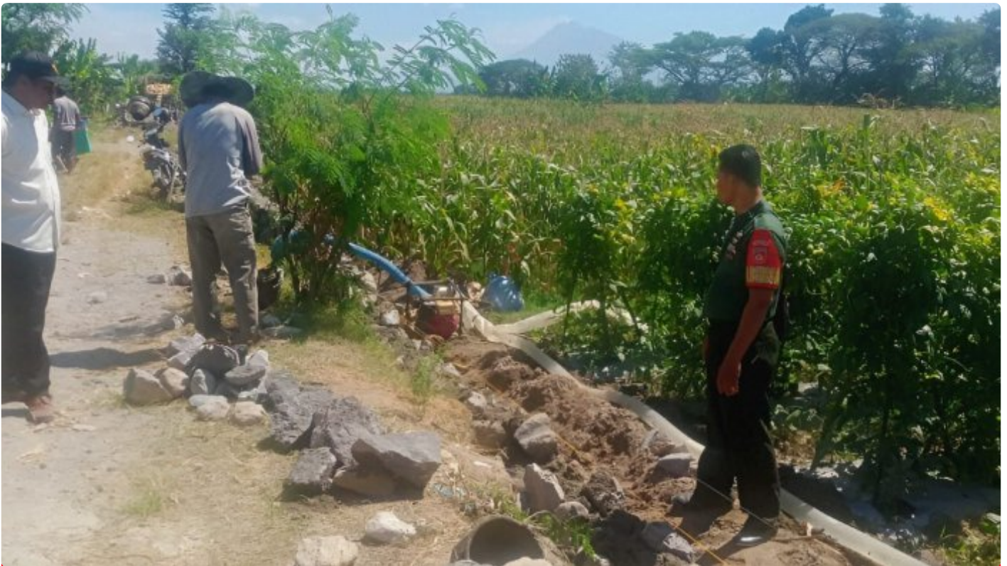
Wujudkan Kemanunggalan TNI dan Rakyat, Babinsa Ceper Bantu Buat Talud
